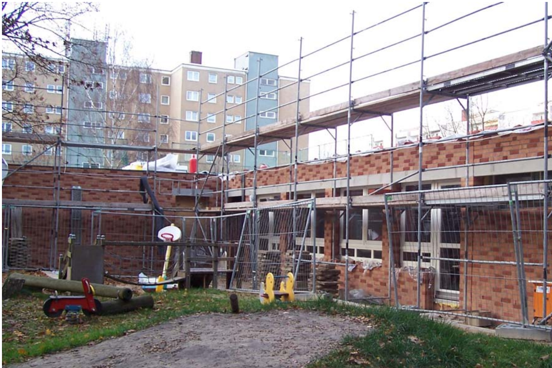
Die Südseite der Kita mit den neuen Fenstern und der neuen Fassade
